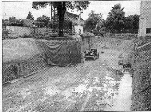
Un parking souterrain de 240 places a été creusé, pour éviter que les voitures soient visibles de la résidence.
